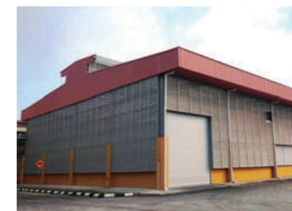
太陽光を活用した乾燥施設
